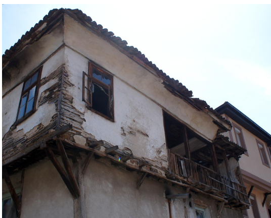
Постојна состојба на јужната фасада евидентни оштетувања на вградените материјали, особено изразени кај дрвените елементи (греди, косници, врата, прозорци...)
