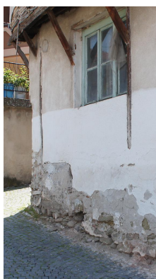
Оштетувања и промени од дополнителни интервенции во приземјето и на катот
