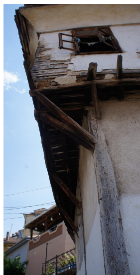
Постојна состојба на јужната фасада евидентни оштетувања на вградените материјали, особено изразени кај дрвените елементи (греди, косници, врата, прозорци...)
