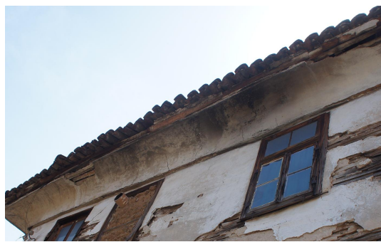
Симс- источна фасада Видливи оштетувања од влага на малтерот и дрвените елементи
