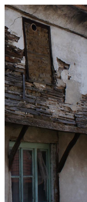
Оштетувања и промени од дополнителни интервенции во приземјето и на катот
