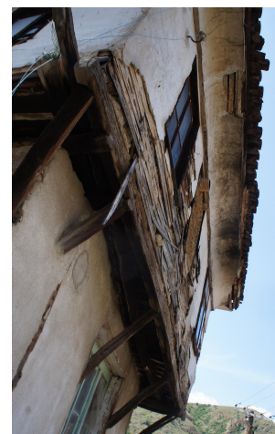
изразен деформитет и деградација на дрвените елементи
